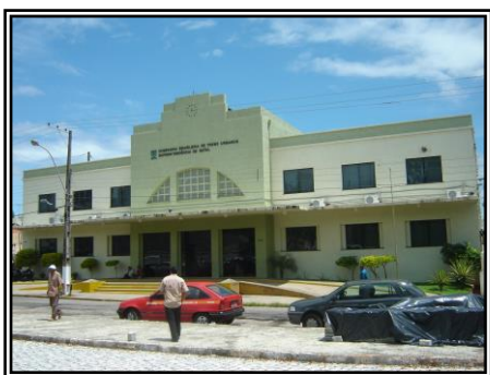
Figura 03 – Fachada principal da CBTU em Natal Fonte: Acervo próprio
