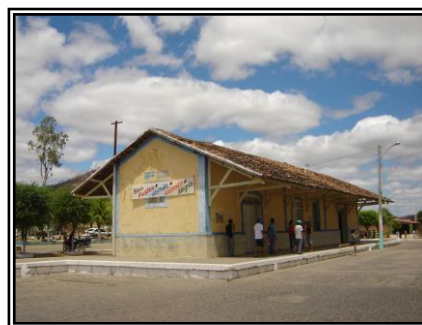
Figura 17 – Estação de Alexandria Fonte: Acervo próprio.
