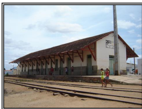
Figura 07 - Estação de Lajes.
