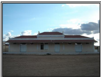
Figura 14 – Estação de Caraúbas após reforma Fonte: Acervo próprio.
