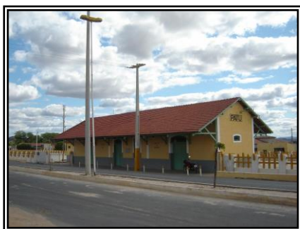
Figura 16 – Estação de Patú Fonte: Acervo próprio.
