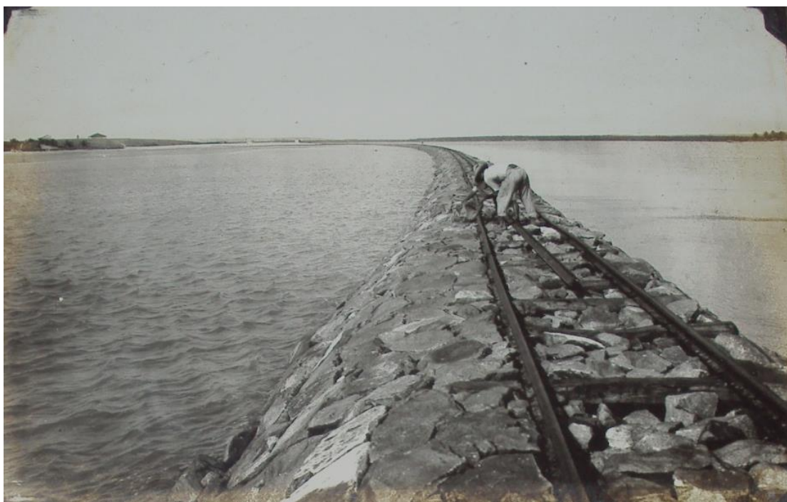
Figura 47. Construção da guia-corrente, 1927. Do lado esquerdo, é possível ver a extensão represada de água que se tornou, paulatinamente, numa área de mangue e de praia.
