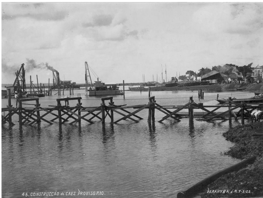
Figura 53. Construção do cais provisório, 1922. A fotografia busca contrapor a estrutura provisória com as operações de dragagem na bacia do ancoradouro, demonstrando o progresso mesmo em situações de precariedade.
