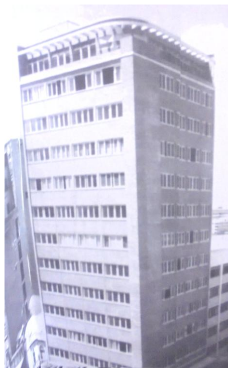
Figura 74 - Rooftop do Ed. Jalcy onde funcionou um dos escritórios de Pinho
