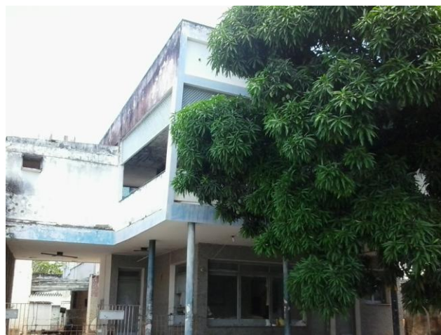
Figura 96 - Edificação com reforma no piso superior, à esquerda
