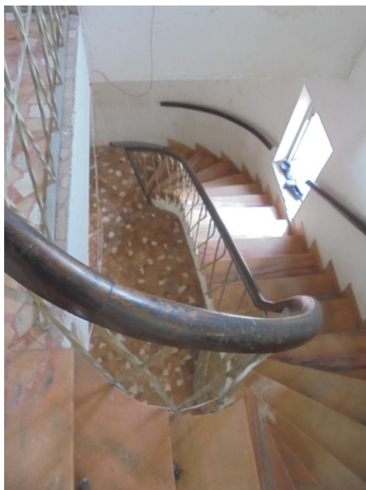
Figura 98 - Escada em mármore, guarda-corpo de madeira polida
