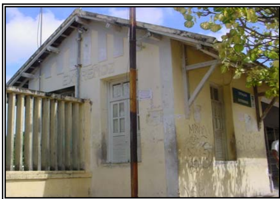
Figura 48 – Estação de Extremoz antes da reforma de 2005 Fonte: CBTU.
