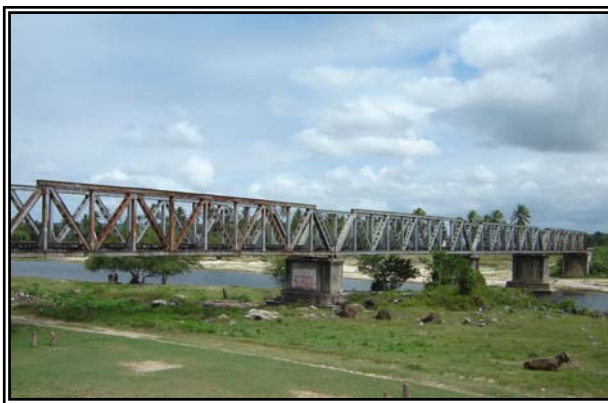
Figura 12 – Ponte sobre o rio Curimataú, 2007. Fonte: Acervo próprio
