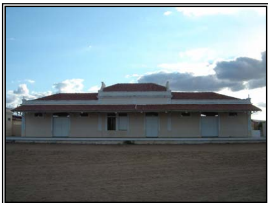
Figura 74 – Estação de Caraúbas após reforma Fonte: Acervo próprio.
