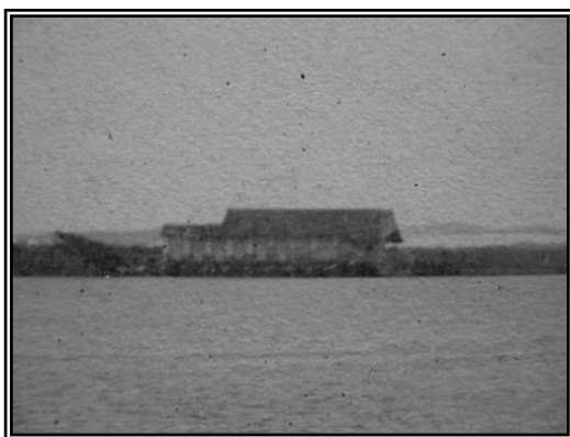
Figura 45 – A estação de Pedra Preta antes de ser demolida Fonte: http://www.estacoesferroviarias.com .
