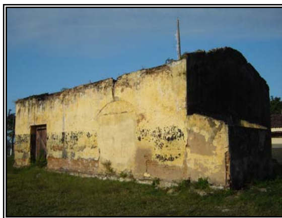
Figura 35 – Antigo armazém de mercadorias Fonte: Acervo próprio
