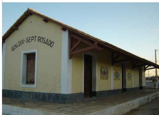
Figura 73 – Estação de Gov. Dix-Sept Rosado Fonte: Acervo próprio.
