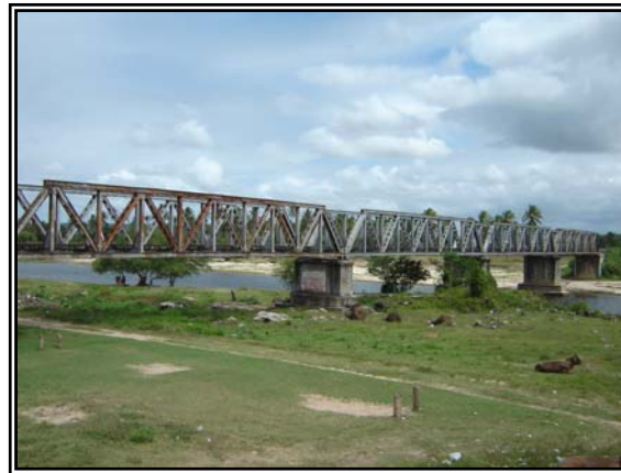
Figura 39 – Ponte sobre o rio Curimataú Fonte: Acervo próprio
