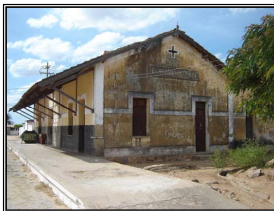
Figura 63 – Estação de Fernando Pedroza, vista 02 Fonte: Acervo próprio.
