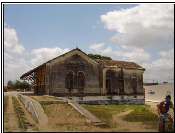
Figura 50 – Estação de Taipu, vista 01. Fonte: Acervo próprio.
