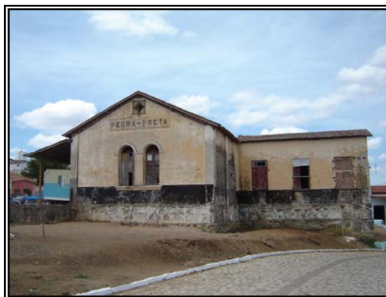
Figura 56 - Estação de Pedra Preta, vista 02.
