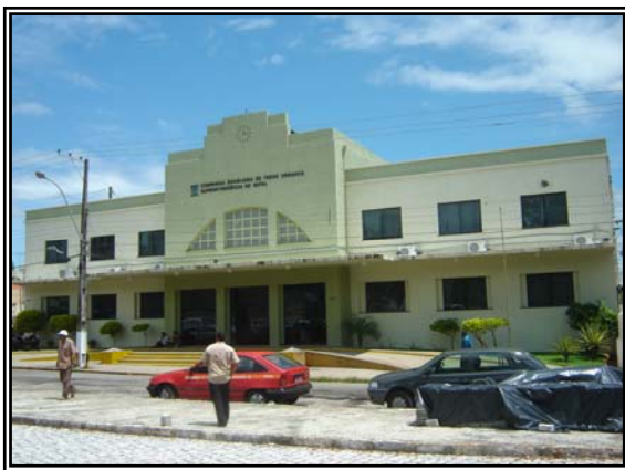
Figura 28 – Fachada principal da CBTU em Natal Fonte: Acervo próprio
