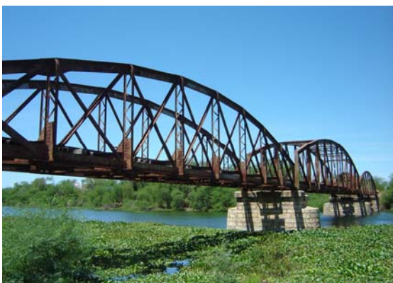
Figura 72 – Ponte sobre o rio Mossoró Fonte: Acervo próprio.
