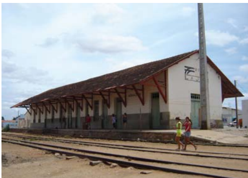
Figura 57 - Estação de Lajes. Fonte: Acervo próprio.
