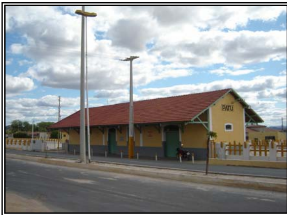
Figura 77 – Estação de Patú Fonte: Acervo próprio.
