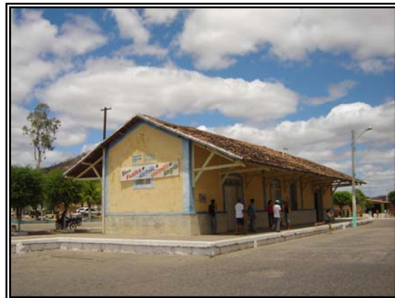
Figura 78 – Estação de Alexandria Fonte: Acervo próprio.
