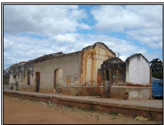
Figura 79 – Estação de Almino Afonso Fonte: Acervo próprio.
