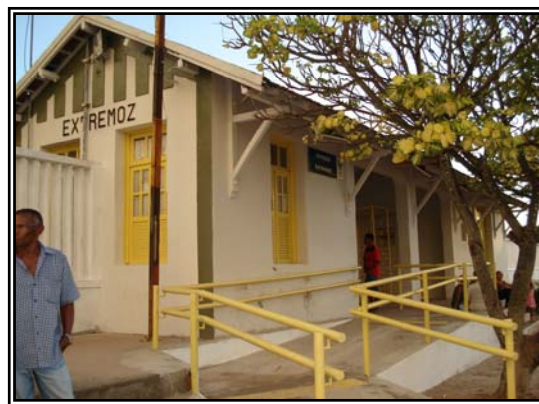
Figura 49 – Estação de Extremoz após a reforma Fonte: Acervo próprio.
