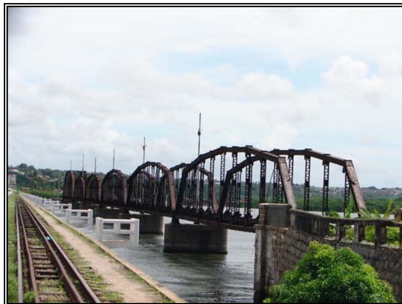
Figura 14 – Ponte sobre o rio Potengi, 2007.
