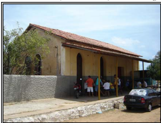
Figura 55 – Estação de Pedra Preta, vista 01.
