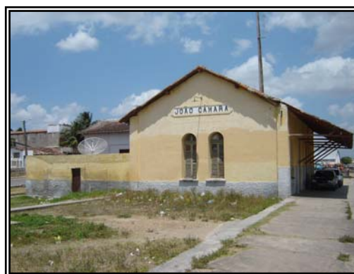
Figura 54 – Estação de João Câmara, vista 02.
