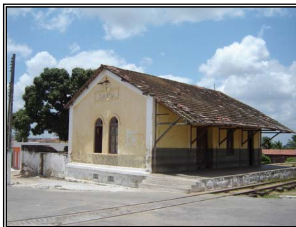
Figura 51 – Estação de Taipu, vista 02. Fonte: Acervo próprio.
