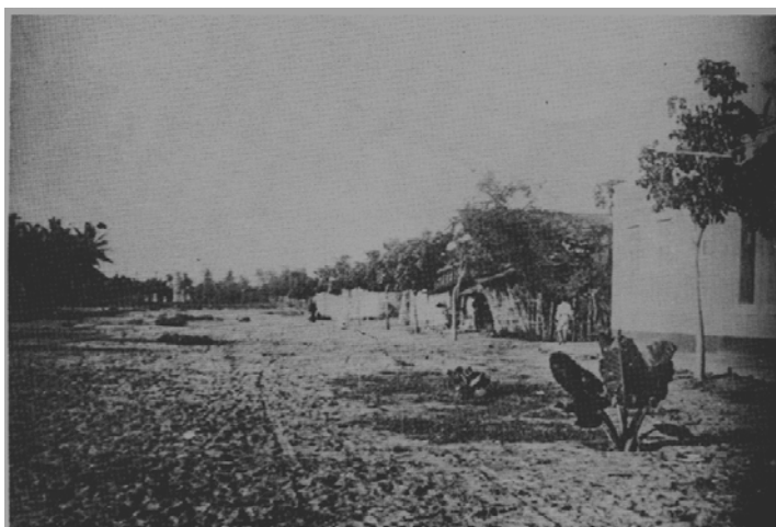
Figura 14: Terreno onde foi construída uma vila pela Construtora Palatinik & Irmãos, em 1935.
