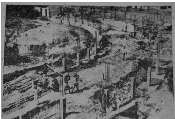
Figura 12: Desapropriação de casas para a construção de um hotel na Ribeira, 1935. Fonte: Diário de Natal.
