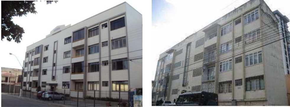
Figuras 06 e 07: Blocos com 8 unidades habitacionais Fonte: Acervo particular dos autores
