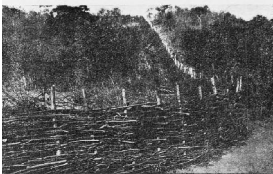
Figura 2. Método usado para fazer cercas.
