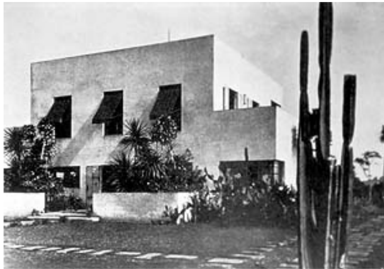
Figura 2: Jardim da Residência na Rua Santa Cruz, São Paulo – Mina Klabin Warchavchik (1928)
